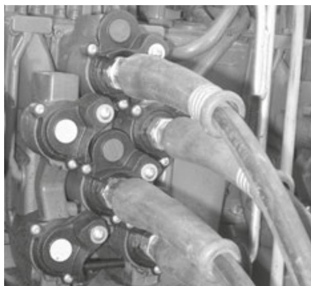
Fig. 84; Déconnexion des conduites hydrauliques
